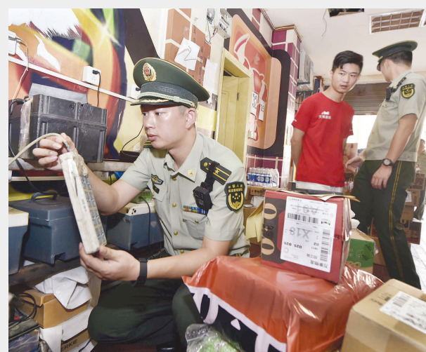
上海日前在全市启动消防安全大排查大整治行动。昨天,杨浦消防支队防火监督警官在双辽路上两家快递分拣处检查时,发现存在乱拉电线充电、店内群组等消防安全隐患,当场开具处罚单予以查封。
