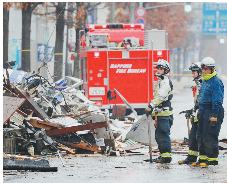
12月17日,在日本札幌市,消防员在爆炸现场工作。
