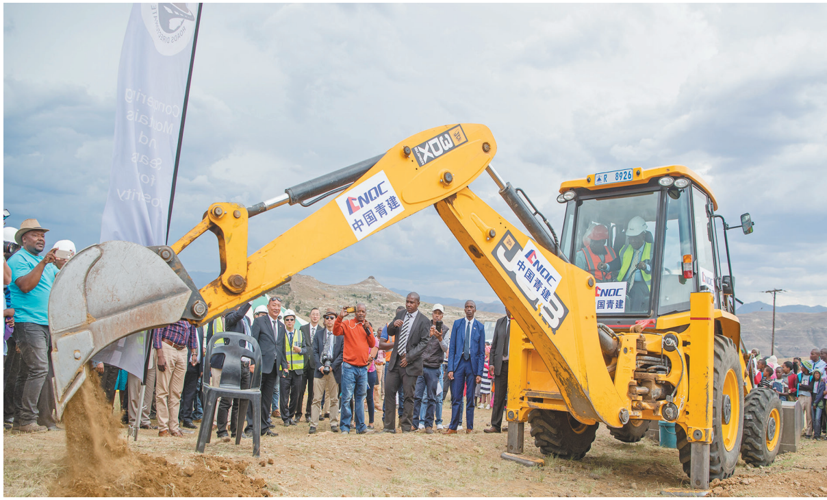
图为12月6日,在莱索托哈姆皮蒂,莱索托首相塔巴内(车内右)在工作人员的指导下驾驶挖掘机,为工程铲出第一铲土。中国援助莱索托道路升级项目6日正式开工。这是中非合作论坛北京峰会后首个在非洲落地的大型双边务实合作项目。
