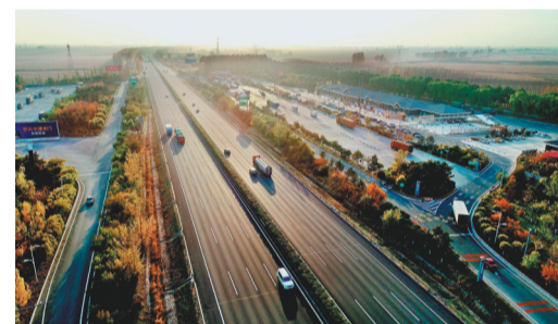
沈大高速公路对沿线各地的经济发展起到了积极的带动作用。
