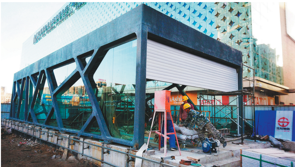
正在装修地面车站。
