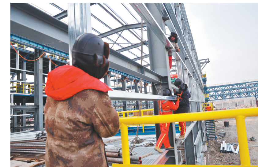
宝来生物能源公司冬季施工抢进度。
