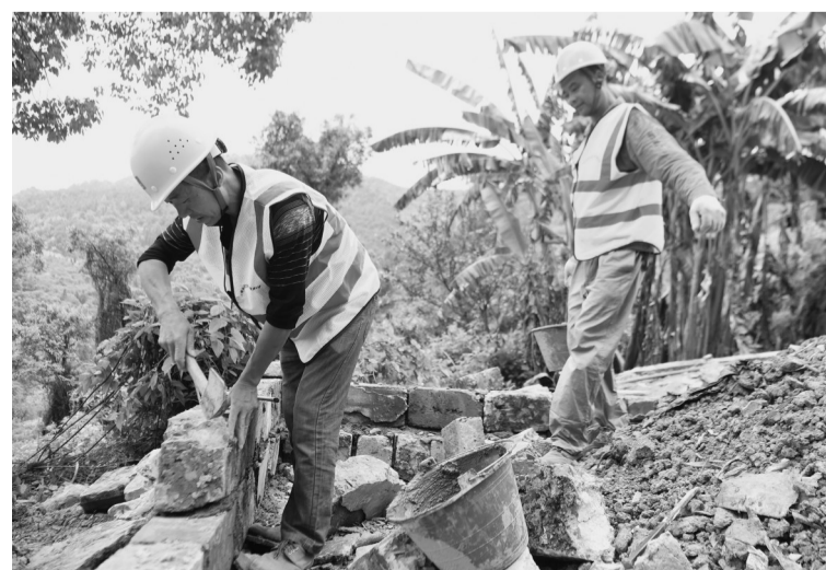
4月29日,施工人员在重庆市渝北区洛碛镇新石村帮助贫困户胡国富修建猪圈。今年以来,中建八局第四建设有限公司在重庆市渝北区洛碛镇确定了9名“脱贫攻坚定点帮扶贫困户”,免费帮助贫困户修建猪圈、水池等设施,助力贫困户发展产业,脱贫致富。
