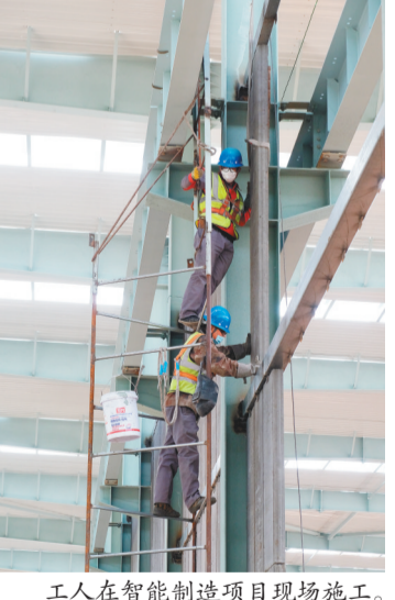
工人在智能制造项目现场施工。
