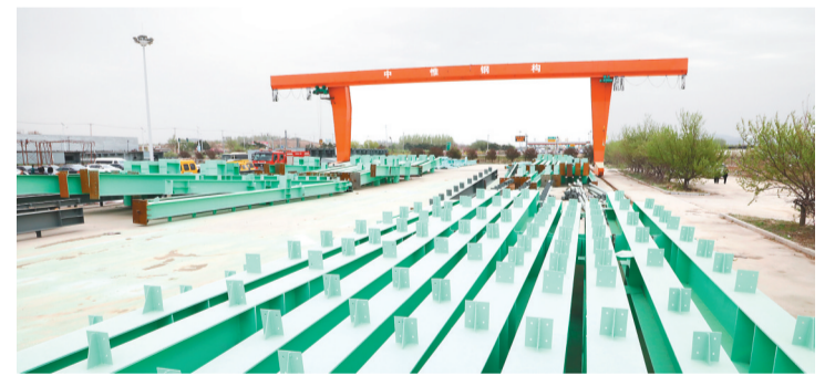
中恒钢结构项目正式开工。 本报特约记者 桂铁军 摄
