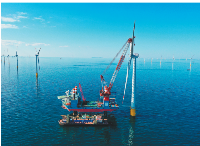
华能大连庄河海上风电场址IV项目风机叶轮与主机舱对接。
