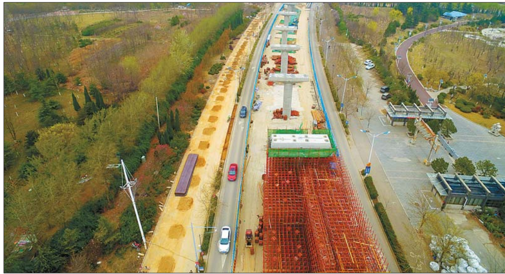
济南地铁R1线长清园博园段正在加紧施工。本报记者 周青先 摄
