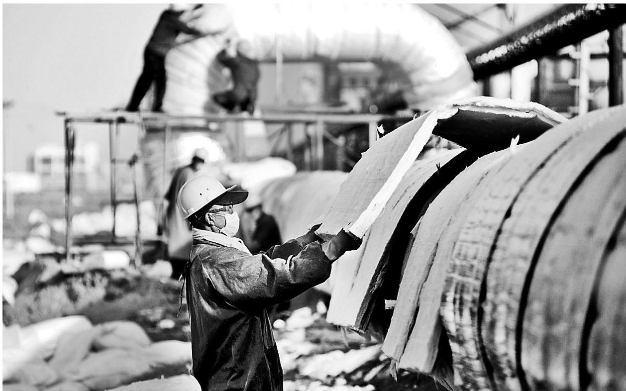
近日,衡水发电厂的施工人员在为东区管道铺设供暖设备。衡水市高新区实施了电厂集中供热工程。该项目采用长输管网技术,将衡水发电厂的蒸汽输送至高新区北区进行集中供热。项目运行后,可淘汰燃煤锅炉18台、燃气锅炉62台,减少高架污染源9个,年减少燃煤22万吨。 记者 焦磊 通讯员 陈康摄
