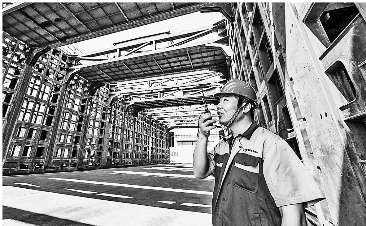
6月4日,在秦皇岛经济技术开发区,工人正调试刚刚下线的地下综合管廊移动护盾机。该设备由秦皇岛天业通联公司自主研发,长63.1米、宽15.8米、高12.6米,具有自动行走、挖挖、工料输送、灌浆、喷水等功能,可有效解决传统工艺设备施工造成的道路中断、噪音、粉尘污染等一系列问题。 记者 赵海江 赵杰摄
