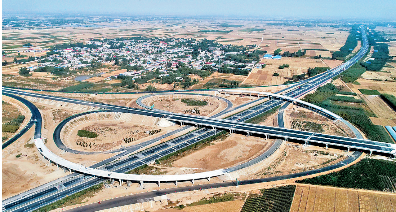
10月6日,曲港(曲阳至黄骅港)高速和大广高速互通立交桥工程紧张施工。目前,曲港高速一期工程进入收尾阶段。曲港高速建成后,将结束安国、博野、蠡县没有高速公路的历史,有效完善我省高速公路网结构。 记者 陈建宇 通讯员 樊连贵摄
