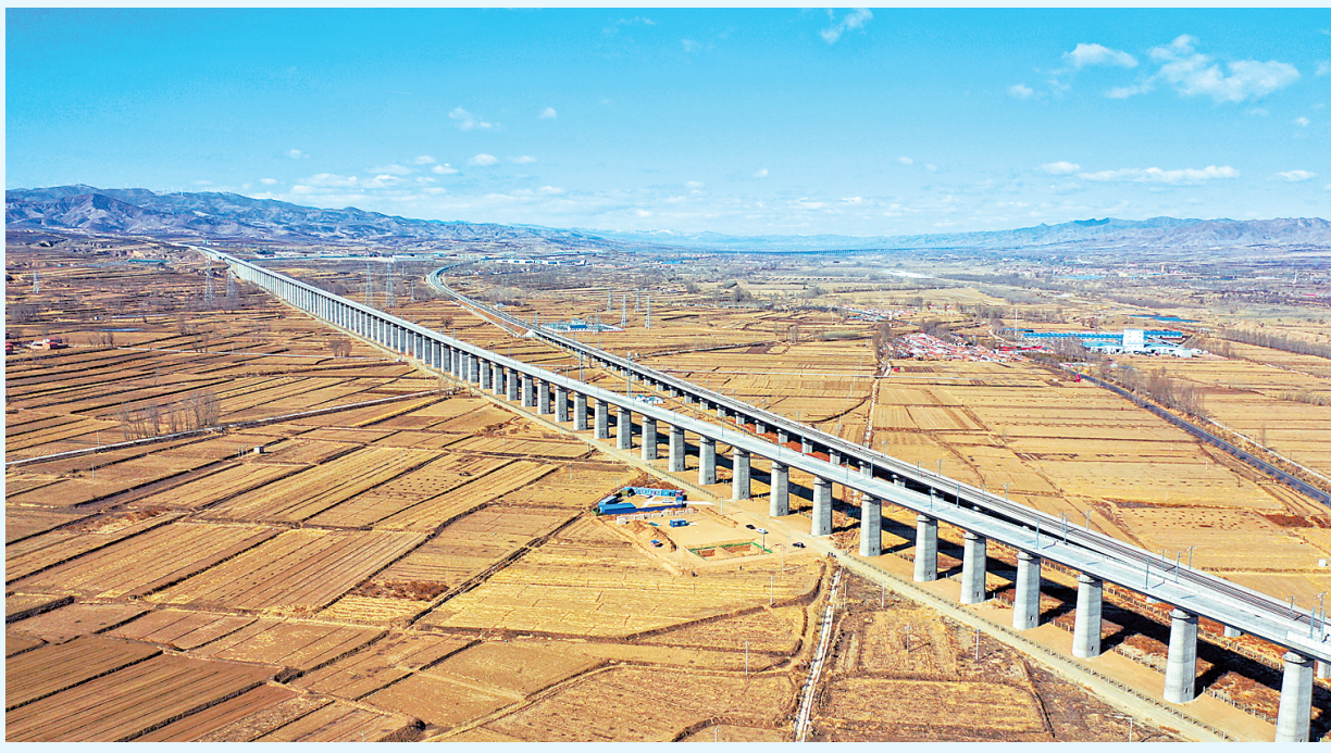
由中铁二十二局集团承建的大张高铁河北段(3月21日无人机拍摄)。3月21日,大(同)张(家口)高铁控制性工程大梁山隧道贯通,标志着2022年北京冬奥会重要配套工程大张高铁线下工程完工,为年底开通奠定了坚实基础。新华社记者 邢广利摄
