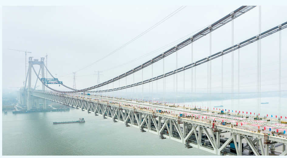
12月26日拍摄的成功合龙的公铁两用悬索桥五峰山长江大桥。当日,我国首座公铁两用悬索桥五峰山长江大桥完成最后两节钢梁焊接,成功实现主桥合龙,该桥是世界上首座千米级高铁悬索桥。五峰山长江大桥连接江苏扬州市与镇江市,是连云港、镇江高速铁路的过江通道。大桥全长6409米,主跨1092米。新华社记者 李博摄
