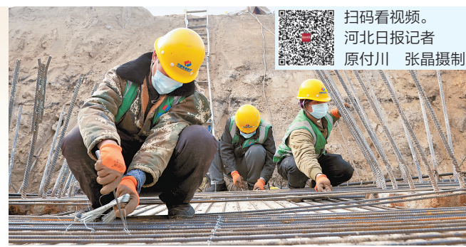
2月10日,中电建路桥集团有限公司K1快速路(一期)项目一标段全面复工。图为工作人员在进行钢筋绑扎作业。河北日报记者 原付川摄
