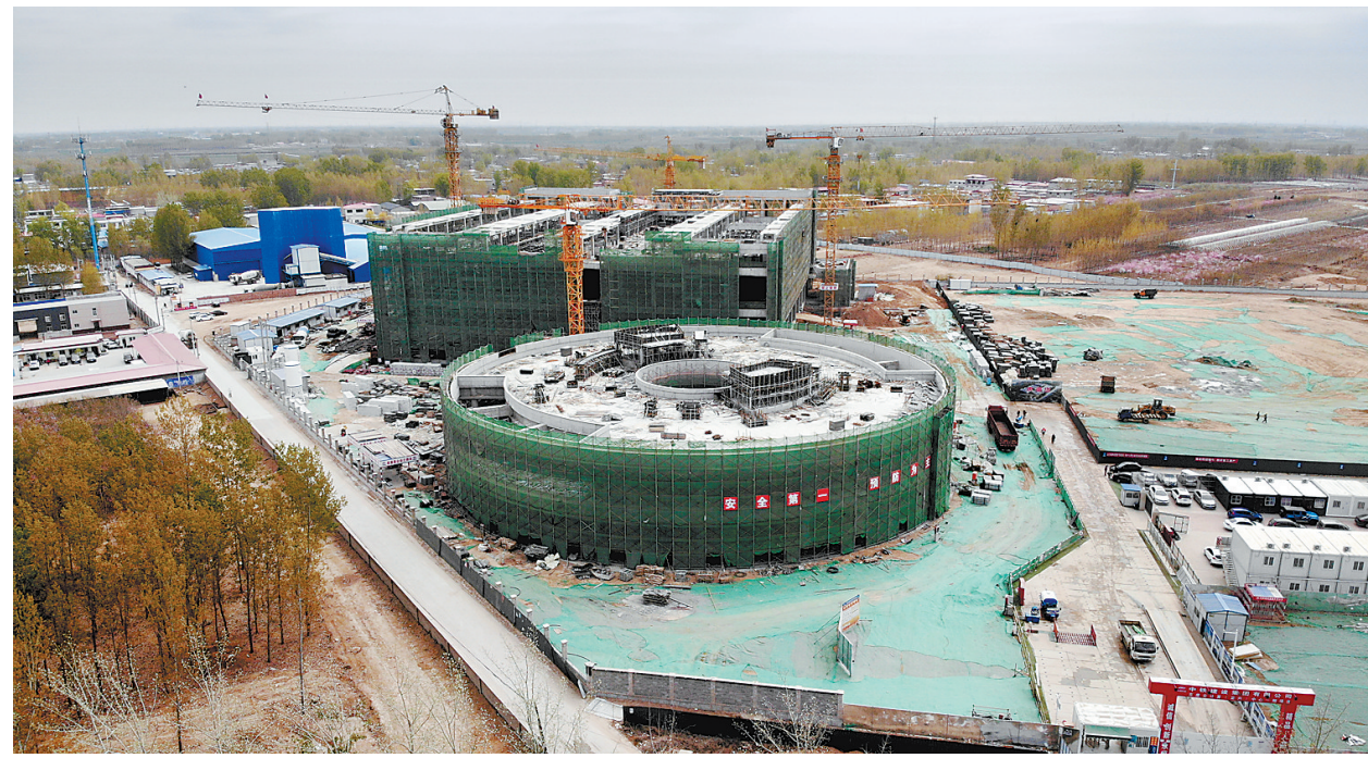
建设中的百度云计算(定兴)中心项目工地。
