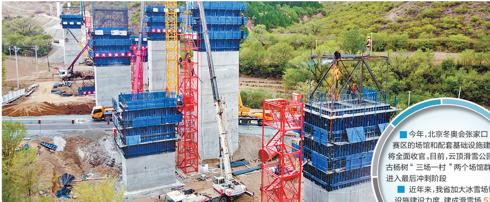
延庆至崇礼高速公路河北段是冬奥会重大交通保障项目，5月19日，延崇高速赤城支线Z2合同段的施工现场一片繁忙。 河北日报记者 耿辉摄
