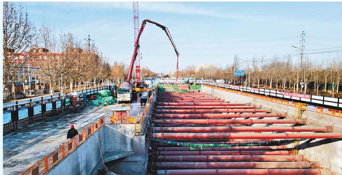
日前,担负北京轨道交通 M22 号线(平谷线)三河市燕郊潮白大街站施工任务的中铁十七局建设者正在进行车站底板防水保护层浇筑施工。
