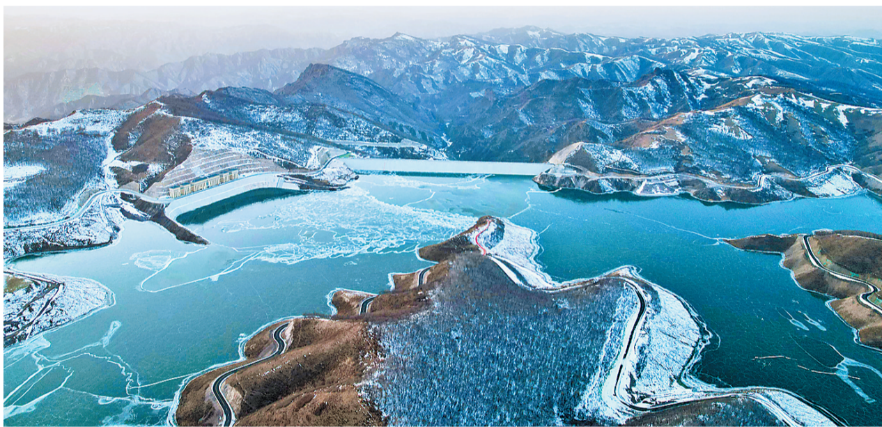
图为丰宁抽水蓄能电站上水库。河北日报通讯员 宋延慧摄
