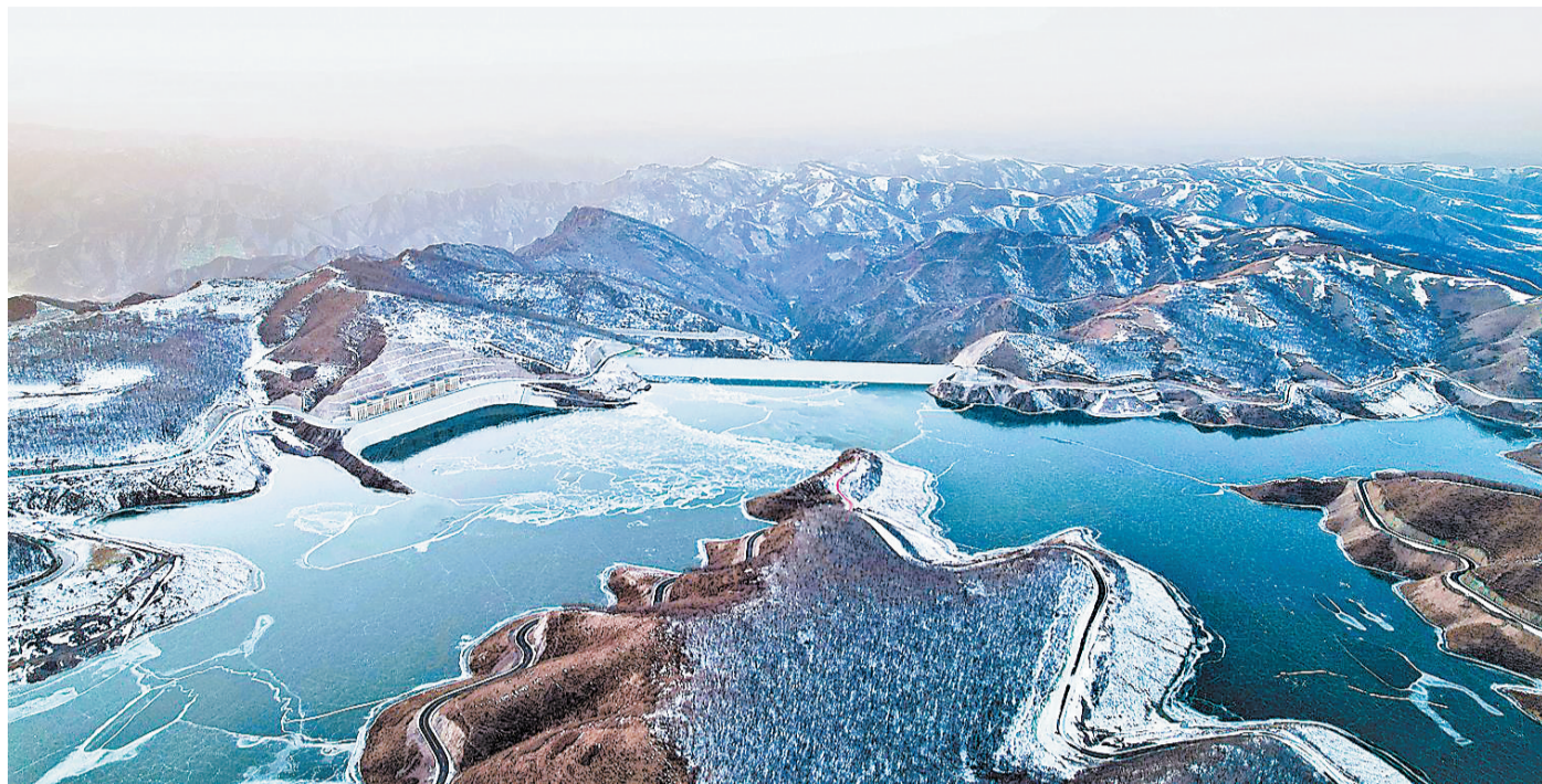
图为丰宁抽水蓄能电站上水库。(本报资料片)
