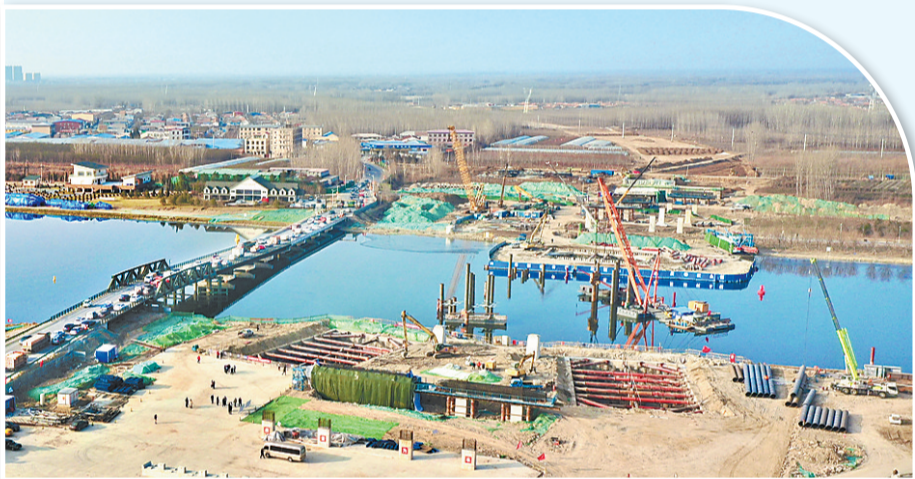
上图:位于香河经济开发区的中粮可口可乐乐华北饮料有限公司生产线。 中图:香河合益包装机械有限公司自动化设备有效节约了人力。 下图:近日,连通香河与北京城市副中心的安石路西延工程新建王家摆桥主桥正在加紧施工。 本组照片由河北日报通讯员贾瑁摄
