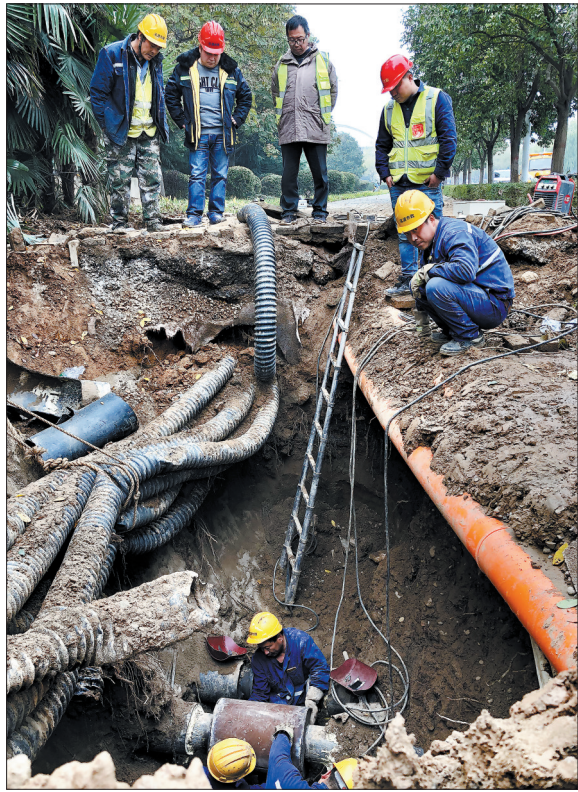
抢修供热管网
