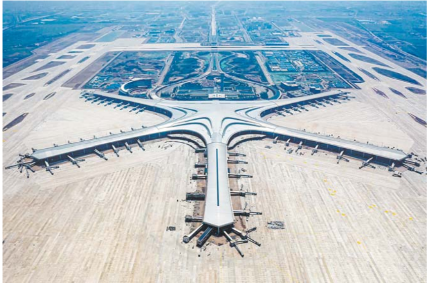
航拍建设中的青岛胶东国际机场。(□CFP供图)
