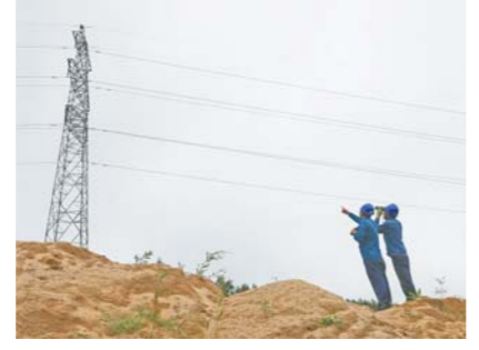
8月26日，国网威海供电公司输电运检人员对塔架进行检修。
