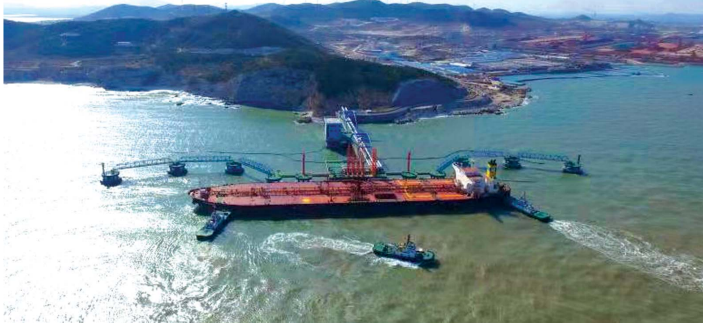
山东港口烟台港西港区30万吨级原油码头正在作业。
