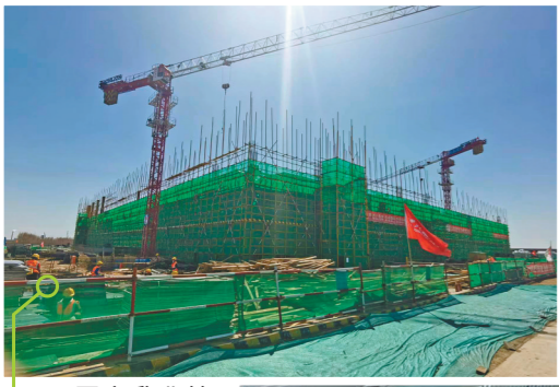
国家乳业技术创新中心总部建设工地。
