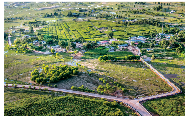
乌审旗新修建的农村公路与景色融为一体。
