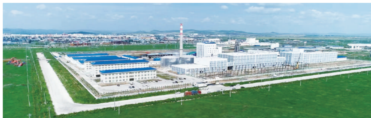
呼伦贝尔晟通糖业科技有限公司厂容厂貌。
