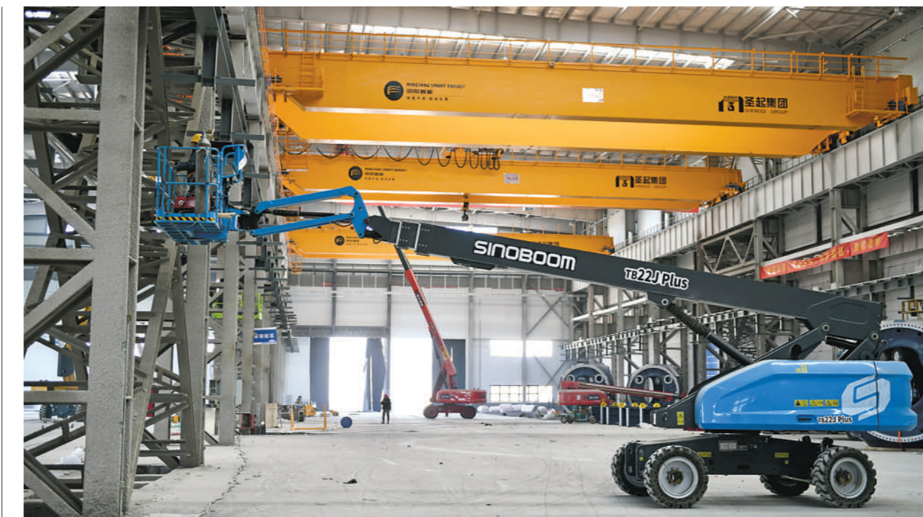
人勤春来早 项目施工忙 2月7日,包头市石拐区中国二冶阳明项目现场施工人员正在加紧施工。从正月初六开始,该项目施工人员进场施工,助力包头千亿级新能源高端装备制造产业集群建设。目前该项目整机车间水电完成总量75%,暖通完成40%,外网管道及配套完成总量的60%。 本报记者 孟和朝鲁 摄
