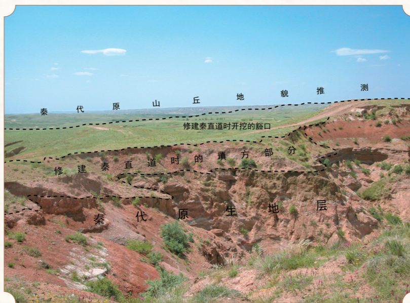
秦直道修筑方式示意图。
