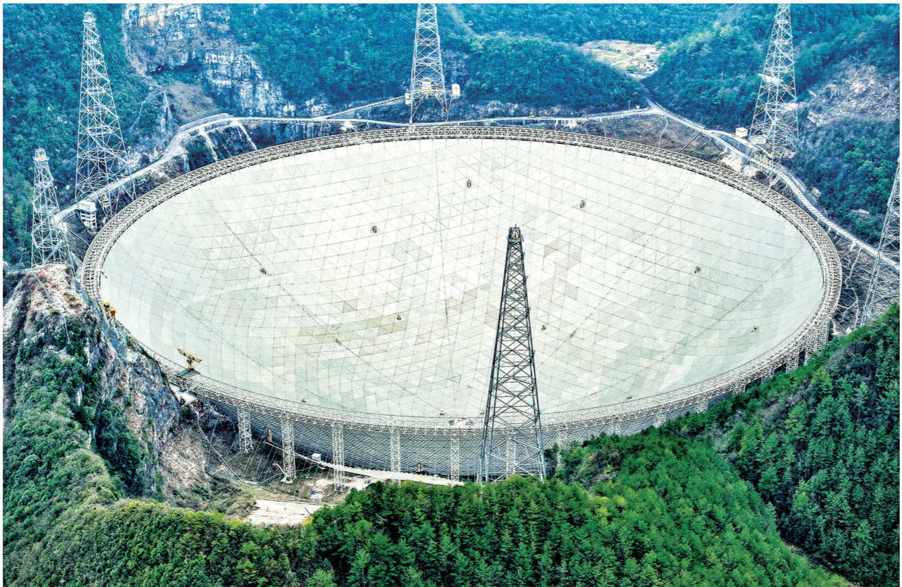
2024年2月26日拍摄的“中国天眼”全景(无人机全景图片,维护保养期间拍摄)。 新华社记者 欧东衢 摄
