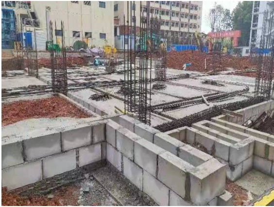
武汉商学院南校区新建食堂项目
