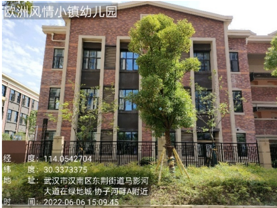
欧洲风情小镇(二期)配套幼儿园新建项目
