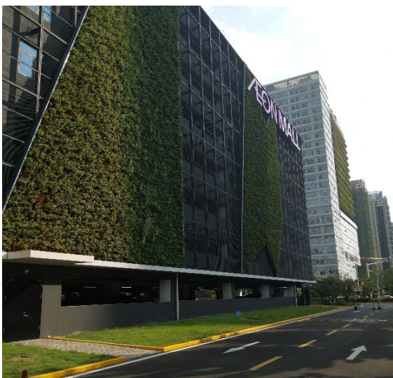
永旺梦乐城武汉经济技术开发区购物中心B区自走式立体停车楼项目图斑认定
