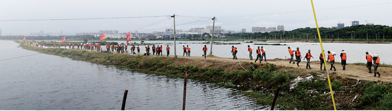
陆军第71集团军某合成旅王杰生前所在连官兵跟随部队在江西共青城市共青联圩共大圩段加固防洪堤坝(2020年7月19日报)。(新华社发)
