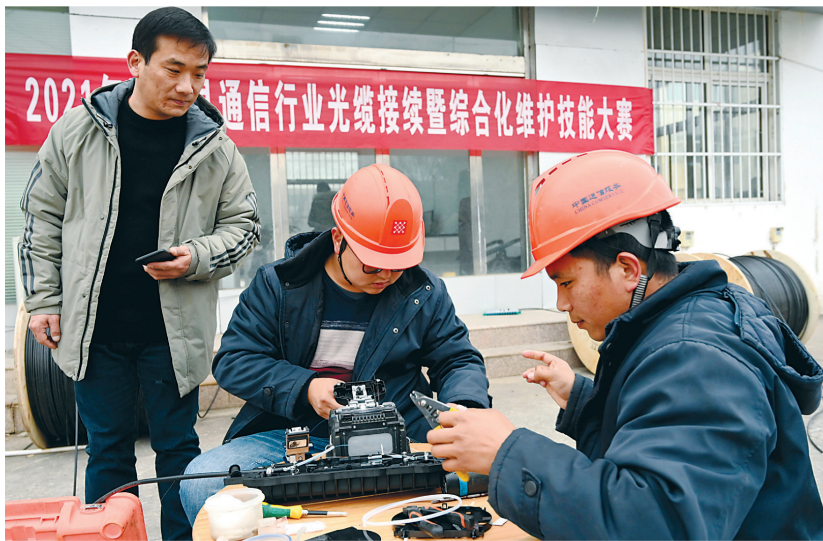
此次比赛旨在提升通信行业综合化维护技能，选拔通信维护能手。图为参赛选手在大赛现场进行光缆接续操作。
