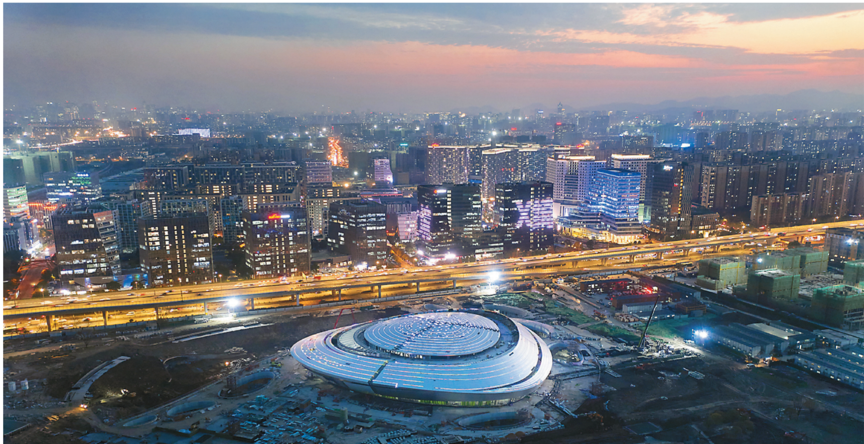
3月31日,绍兴棒(垒)球体育文化中心、绍兴柯桥羊山攀岩基地先后通过赛事功能验收。至此,历时近5年建设后,杭州2022年亚运会、亚残运会56个竞赛场馆全面竣工并通过赛事功能综合验收。图为2021年12月27日拍摄的杭州电竞中心(无人机照片)。
