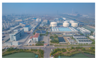
工业废水综合治理中心
