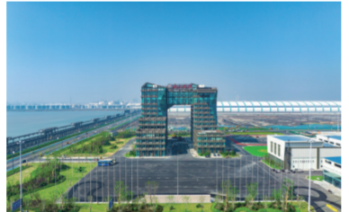
徐圩港区综合调度指挥中心
