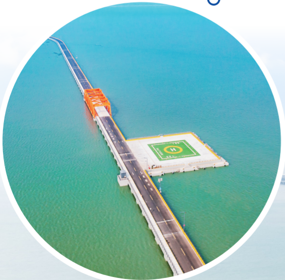
海上应急消防通道
