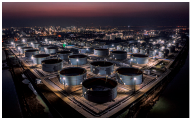
盛虹炼化罐区
