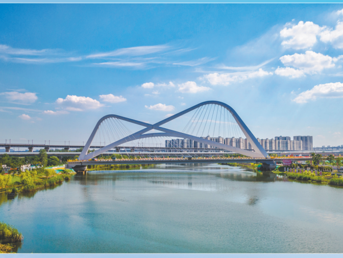
衔接南部新城对外通道的关键节点工程——秦淮湾大桥
