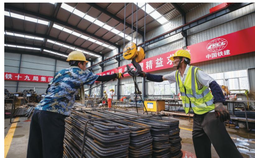
7号线丁家庄站钢筋生产现场
