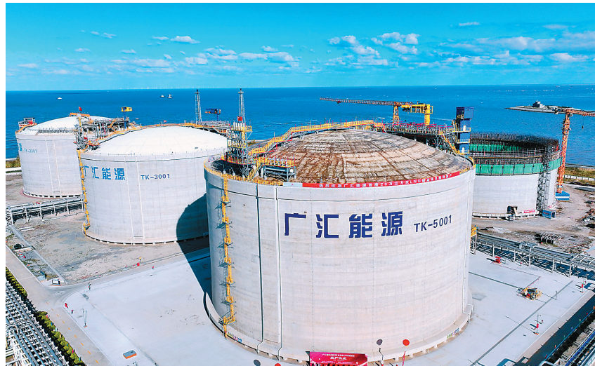
12日,广汇能源启东LNG接收站首座20万立方米LNG储罐项目正式投用。本次投用的20万立方米LNG储罐,2020年5月开工建设,今年9月交工验收、完成消防验收、通过试生产评审,已完成了干燥、置换和预冷等各项投产准备工作,具备投用条件。
