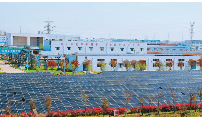
盐海化工公司5.9兆瓦光伏项目
