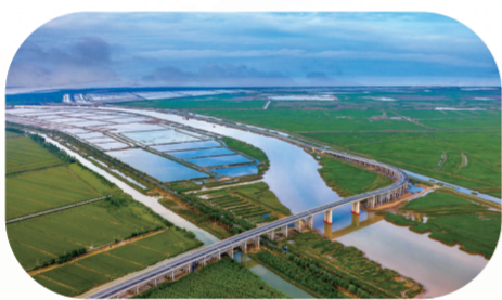
湿地观光大桥
