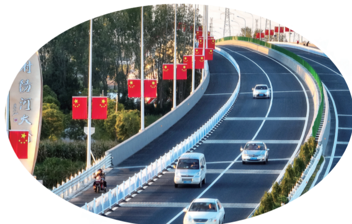
合海线射阳河大桥
