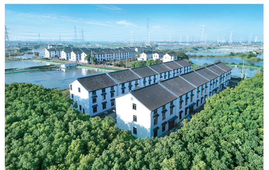
常熟市沙溪镇近年来创新实施“整村移位”翻建模式,以沙南村裴家庄自然宅基和横泾村泾西自然宅基等点位为试点,稳步推进“千村美居”工程,提升农村人居环境。图为近日航拍的沙南村裴家庄自然村“整村移位”项目。
