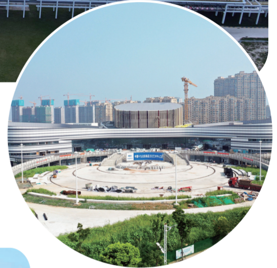
建设中的滨海县文化艺术中心
