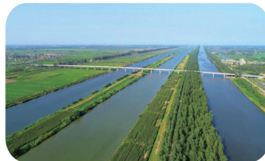
列入国家重点工程的淮河入海水道二期工程
