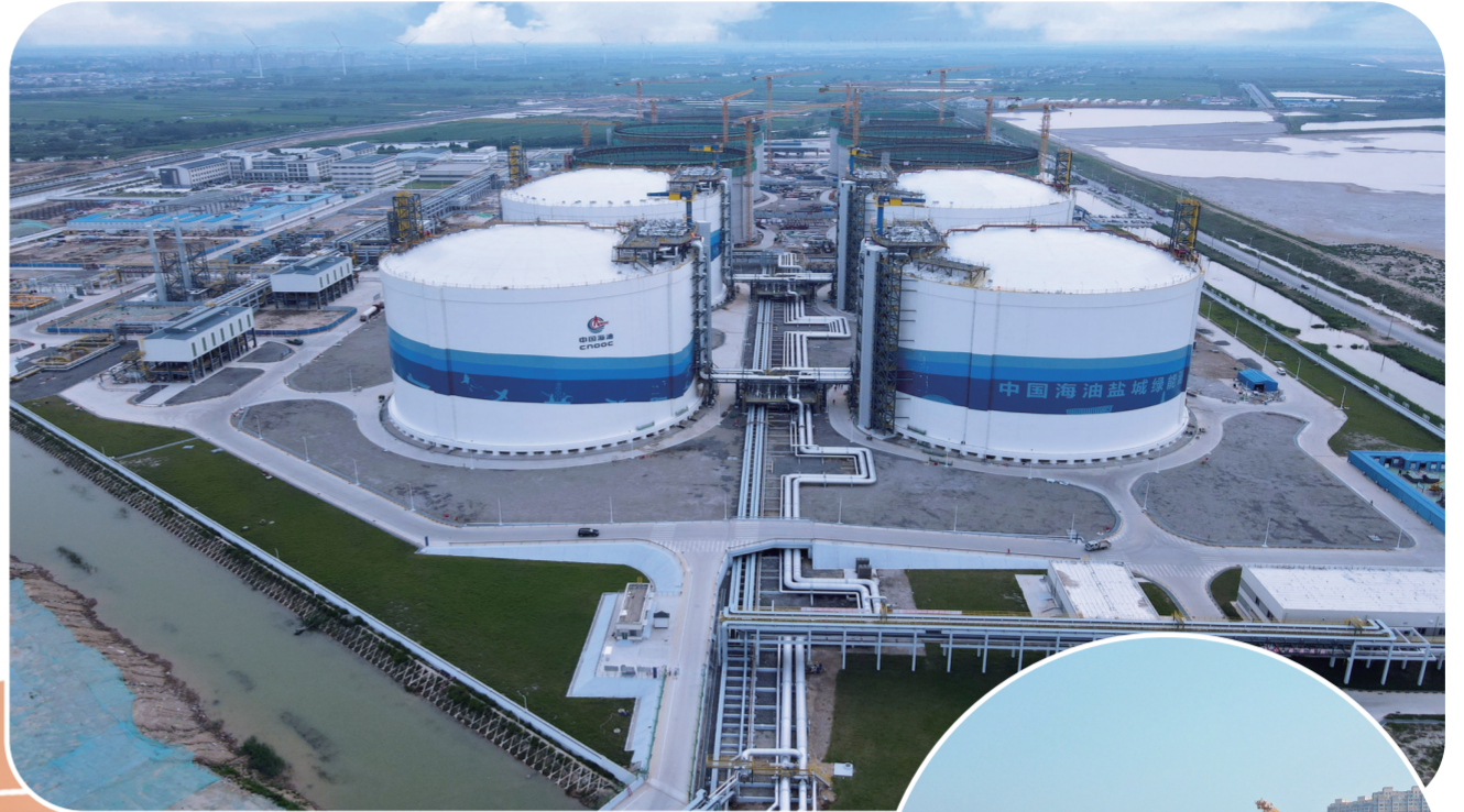
坐落于滨海片区的中海油盐城绿能港项目
