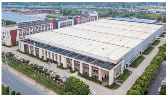
清华大学扬州智能科技装备园
