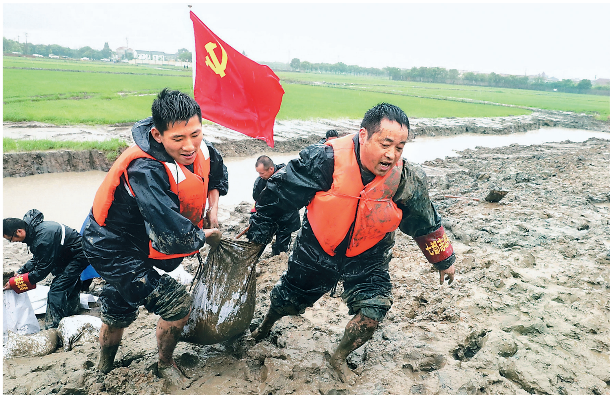
苏州市吴江区党员干部身先士卒,在汛期加固内河堤坝。 华雪根 摄
