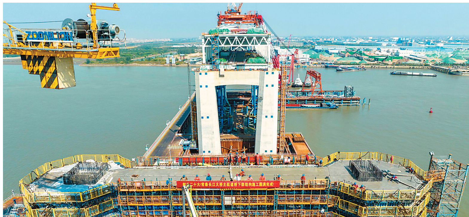
昨日，世界在建最大跨度公铁两用斜拉桥——常泰长江大桥四墩墩梁浇筑完成，标志着主航道桥下部结构施工圆满转入上部结构施工阶段。赵振宇、朱江浦摄（视觉江苏网供图）
