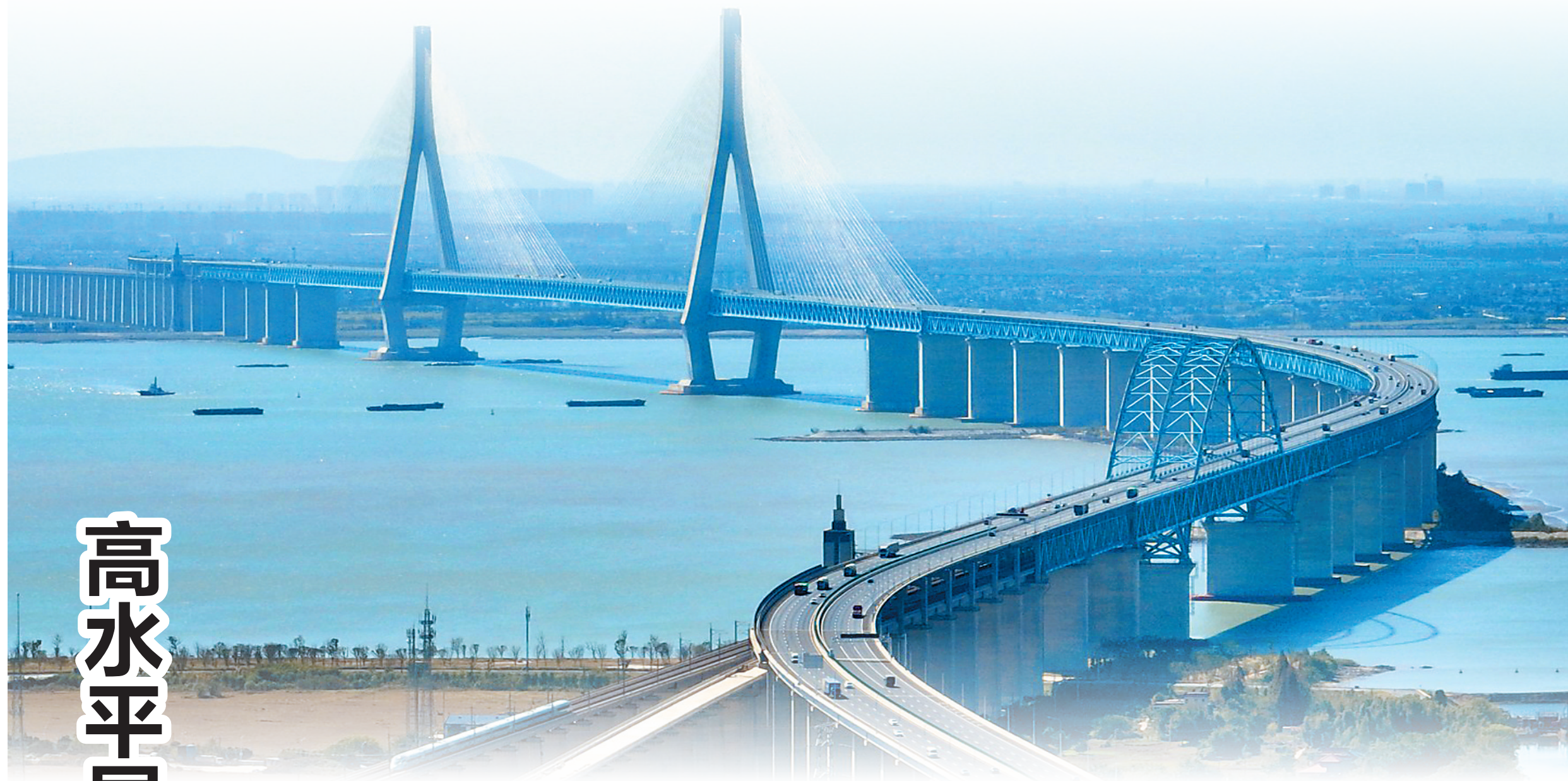
10月18日拍摄的沪苏通长江公铁大桥。 许丛军 摄(视觉江苏网供图)
