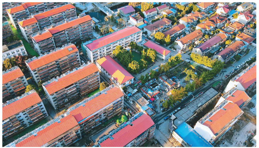
19日,如皋市如城街道安坝社区境内的一处老旧小区房屋及立面墙工程改造已完工,红色屋顶给人焕然一新的感觉。 吴树建 摄(视觉江苏网供图)
