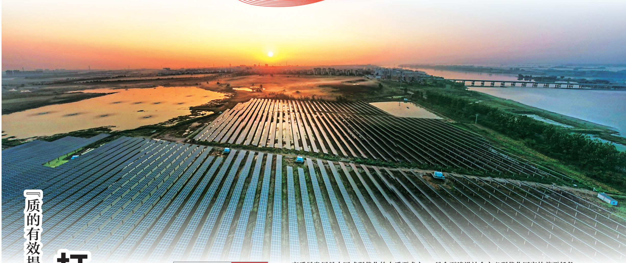
秋天的水乡别有一番景色。图为泗阳县双沟镇境内新能源产业基地,光伏矩阵与碧水良田相映成趣。 朱鹏程 赵淑柳 摄(视觉江苏网供图)
